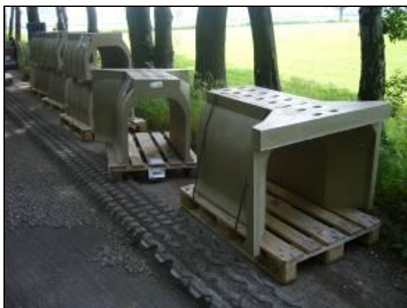
foto's Bert van Opzeeland: aanleg dassentunnel De Heikant.
