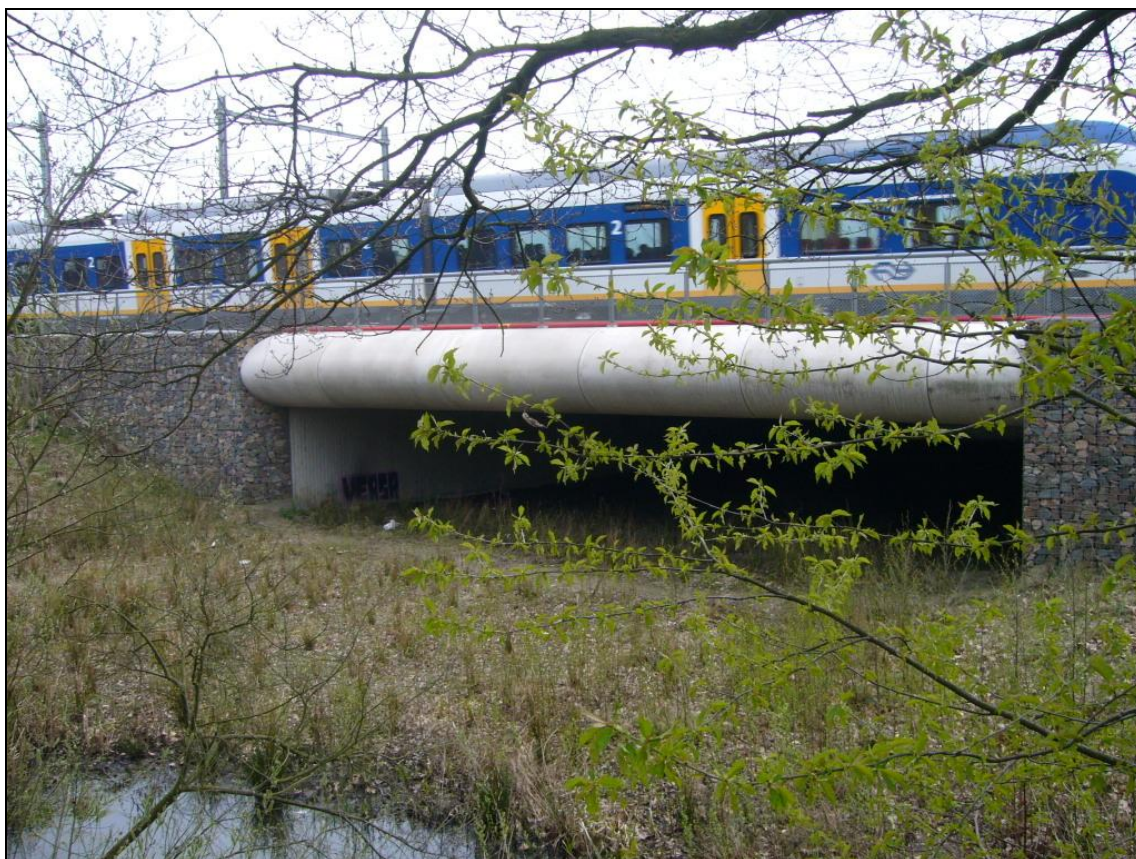
foto Bert van Opzeeland: faunatunnel onder de spoorlijn 's-Hertogenbosch – Eindhoven/Tilburg.
