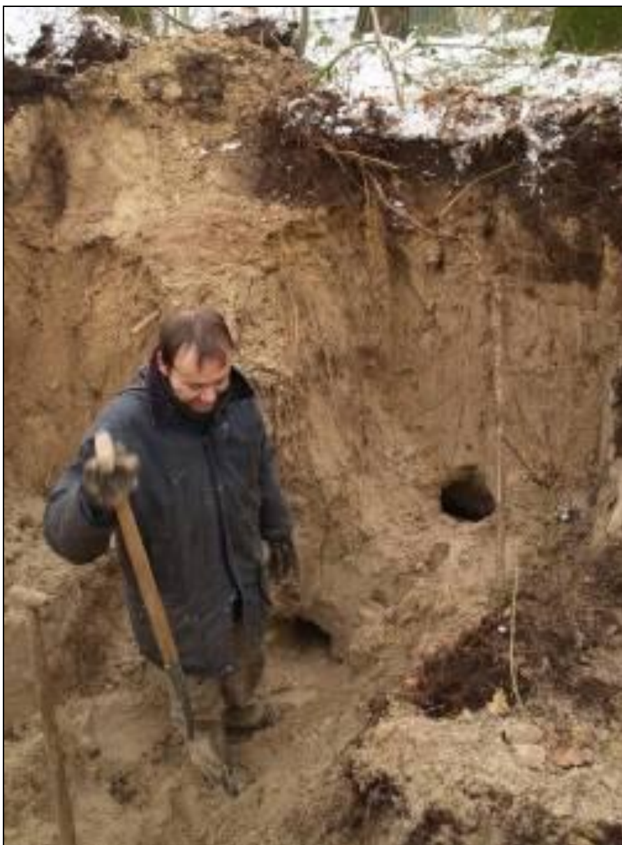
foto Bert Hesse van Das&Boom: Marc Moonen van Das&Boom tijdens de ontmanteling van de burcht in de dijk van het Drongelens kanaal.
